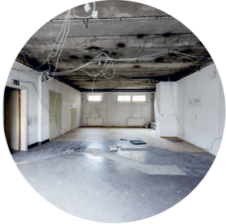
Das C2C LAB vor der Sanierung
