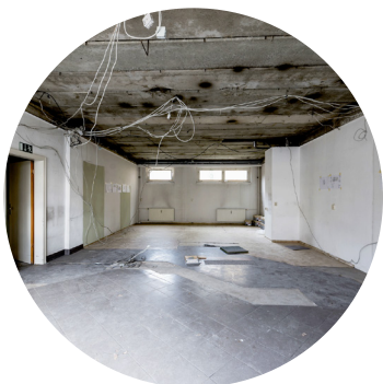
Das C2C LAB wurde vor der Sanierung von Schadstoffen befreit
